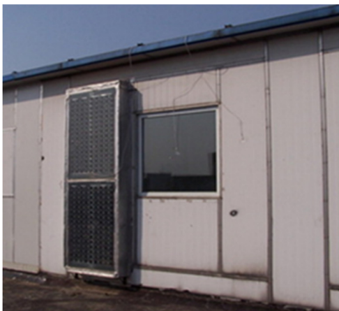
Рис. 9 Фотоэлектрическая стена и окно
