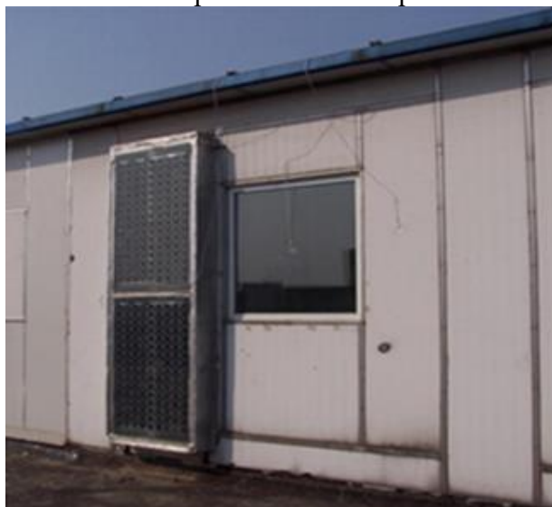
Рис. 9. Фотоэлектрическая стена и окно
